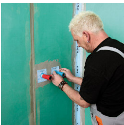
... trekk så tetningsmansjetten forsiktig over proppen og på forlengelsesstykket ...
