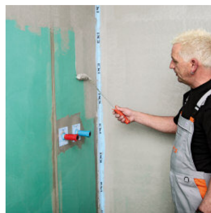
Påfør deretter membranen på resten av overflaten.
